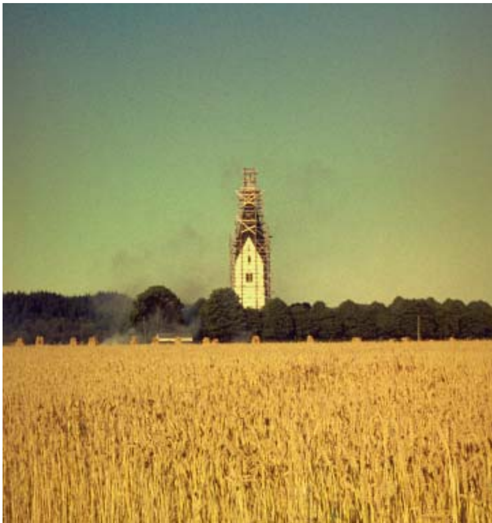
När tornet behövde renoveras år 1964 användes ännu ställningar av trä.
