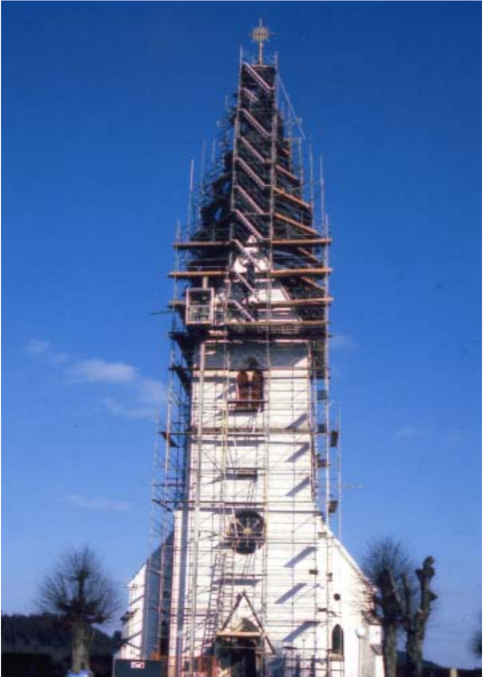
Taket på långhuset och tornet byttes helt 1997.
